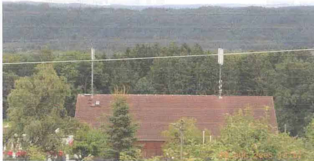
Foto: Blick vom Messpunkt auf die Sendeanlage
