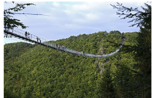
Bild: Martin Reinke: Hängeseilbrücke Mörsdorf https://www.rheinhunsrueck-bild.de
