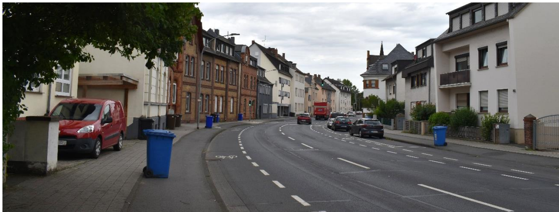
Abb. 3: Bestandssituation Mayener Straße
