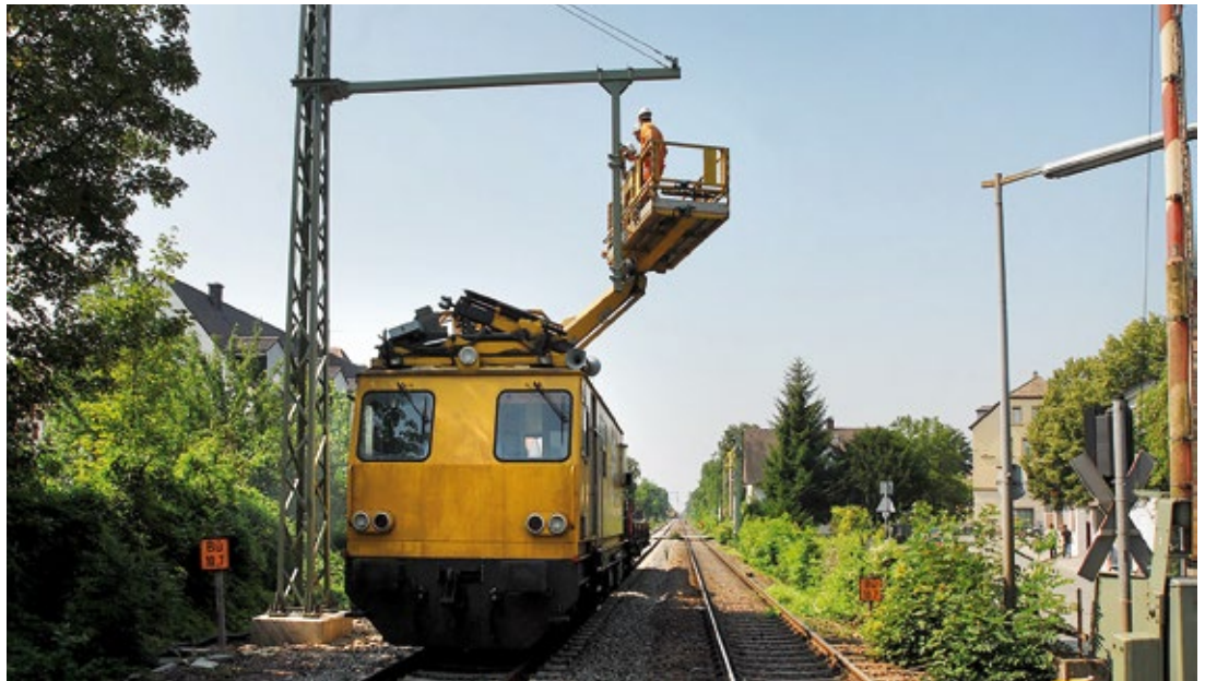
Bild 4 Elektrifizierung der Strecke Schifferstadt – Wörth (Foto: www.foto-lenz.de)
