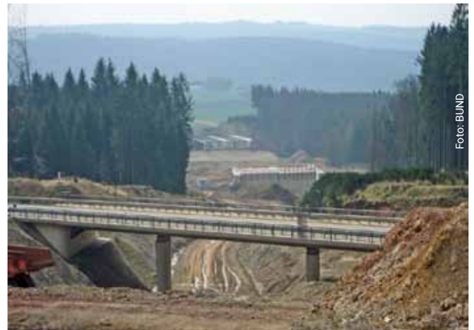
Natur- und Klimaverträglichkeit sieht anders aus: die A1-Baustelle bei Dreis-Brück/Eifel
