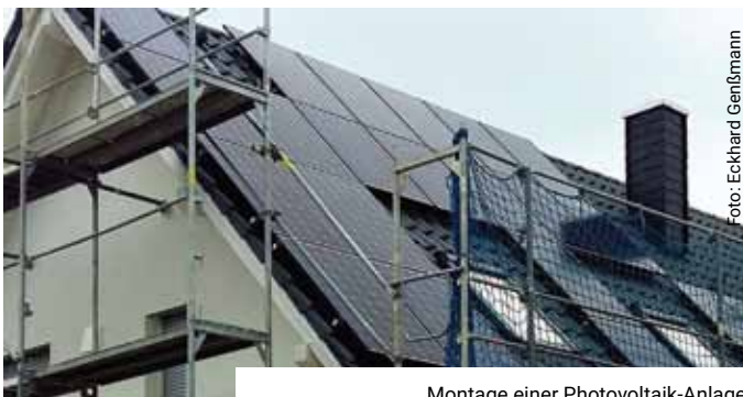
Montage einer Photovoltaik-Anlage (Nennleistung von 9,9 kWp)
