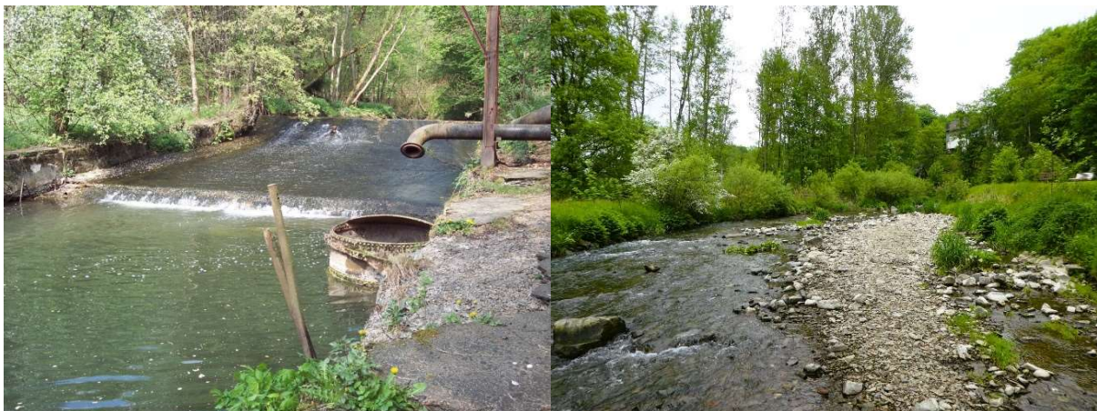
Wehr ehem. Friedrichshütte vor und nach dem Umbau
