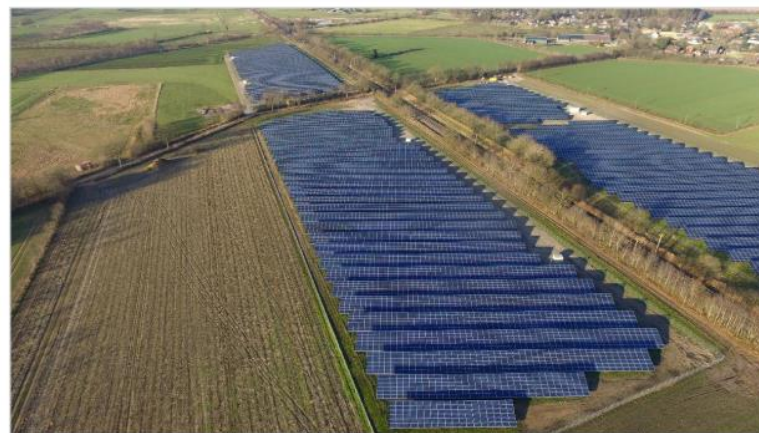
Abbildung 18: Photovoltaik-Freiflächenanlage entlang einer Eisenbahnstrecke (© F. Steinmann, LLUR)
