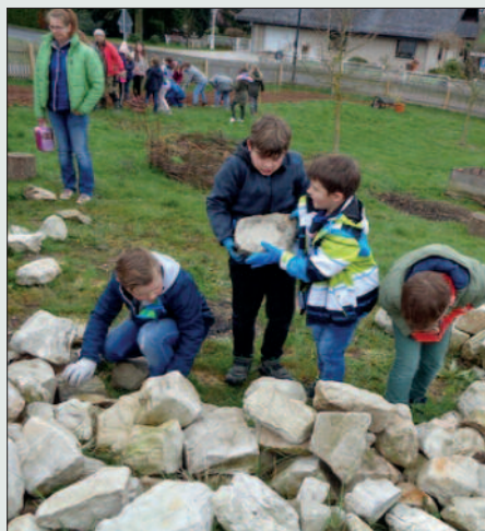
Ganz schön schwer - die Steine für die Trockenmauer
